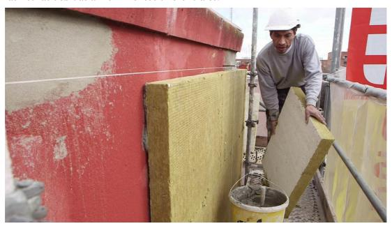
El material aislante que se ha elegido es la lana de roca de 8 cm de espesor<sup>3</sup>, 2cm por encima de lo que se prevé en el CTE, y un coeficiente de conductividad de al menos  $\lambda \le 0.037 \,\mathrm{W/mK^4}$ . Se ha elegido este material, principalmente, por sus buenas propiedades como aislamiento térmico y acústico.
