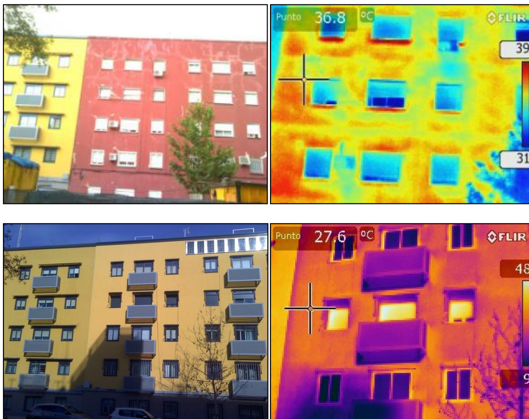
Ilustración 2. Termografías de la fachada trasera del edificio antes (arriba) y después (abajo) de la implementación de las medidas
