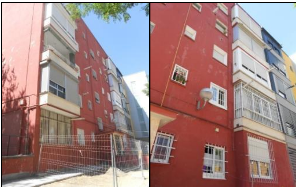
Ilustración 10. Imágenes de los cerramientos de fachada.
