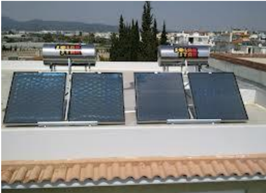
Ilustración 24. Instalación de funcionamiento por termosifón.
