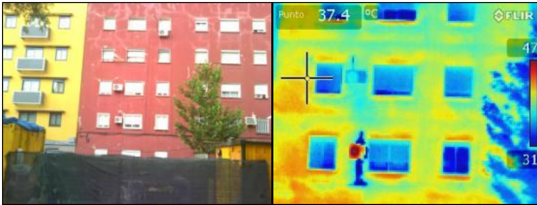
Ilustración 12. Termografías de la fachada trasera del edificio.
