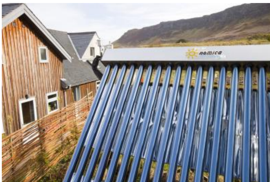
Ilustración 28. Colector de tubos de vacío (fuente: WWF)
