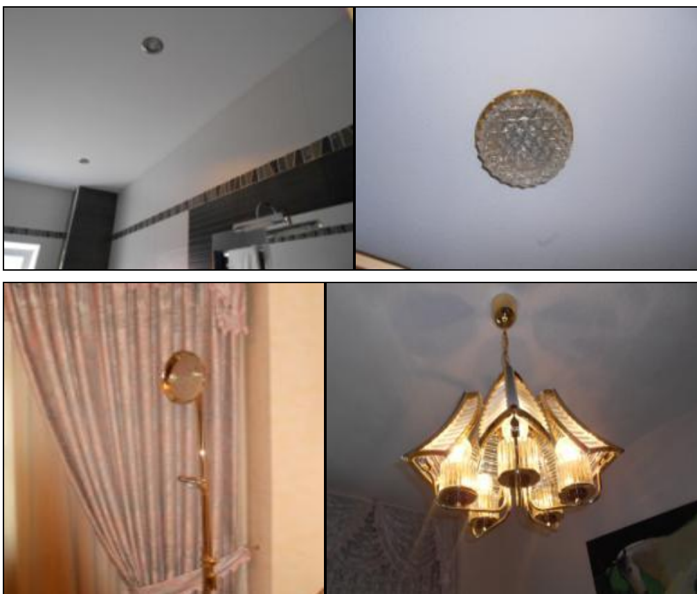
Ilustración 9. Diversos equipos de iluminación instalados en las viviendas
