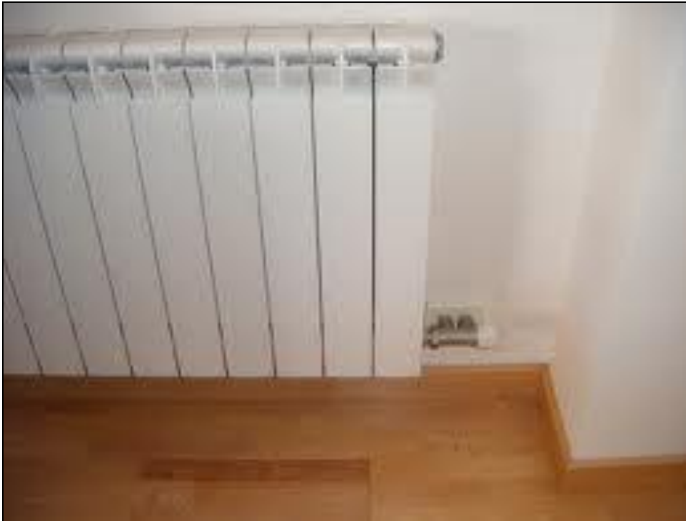
Ilustración 3 . Radiador de agua instalado
